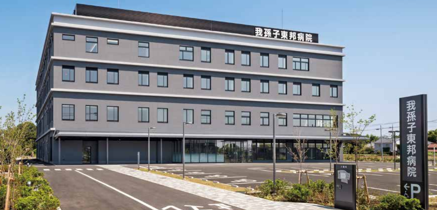
南側外観 濃灰色を基調とし、小庇の水平ラインによってモダンなホテル調の病院外観計画
